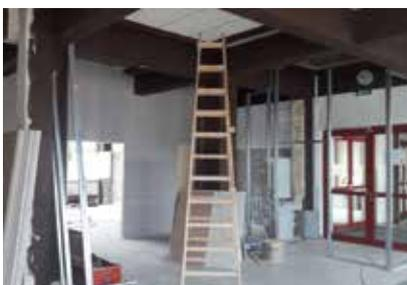
her wird die ehemalige Schulküche zu zwei modernen Gruppenräumen umgebaut. Über die Sommermonate werden Zwischenwände errichtet, ein neuer Boden verlegt und eine neue LED-Beleuchtung installiert. Um auch für den Mittagstisch optimal gerüstet zu sein, werden außerdem ein Küchenblock installiert und für alle Räume neues Mobiliar angeschafft. „Die Fertigstellung der Arbeiten erfolgte noch im August, sodass die adaptierten Bereiche mit Schulbeginn nutzbar sind“, so Bgm. Natascha Matousek. ■
